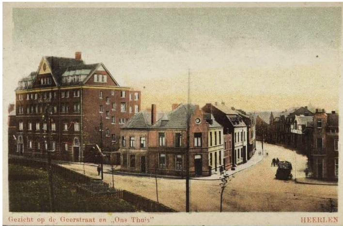
Hoek Geerstraat-Parallelweg vóór aanleg van de tunnel.
