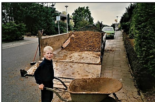
Jeroen helpt bij de aanbouw, 1986
